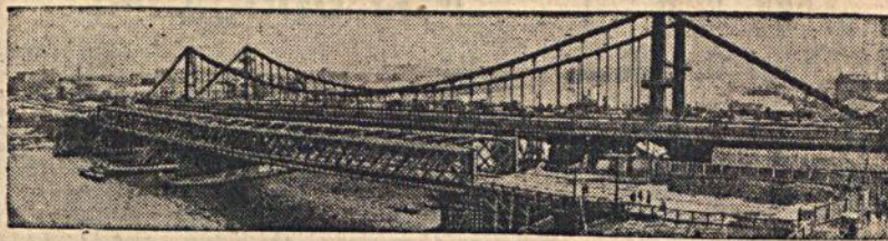
На снимке: Общий вид нового Крымского моста.
